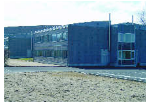
le bâtiment de l'internat
