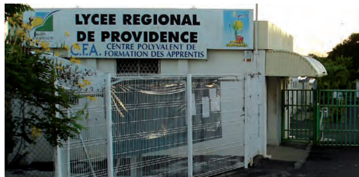
Entrée du Lycée
