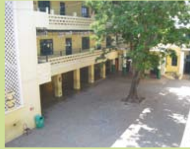
Vue intérieure de l'élémentaire
